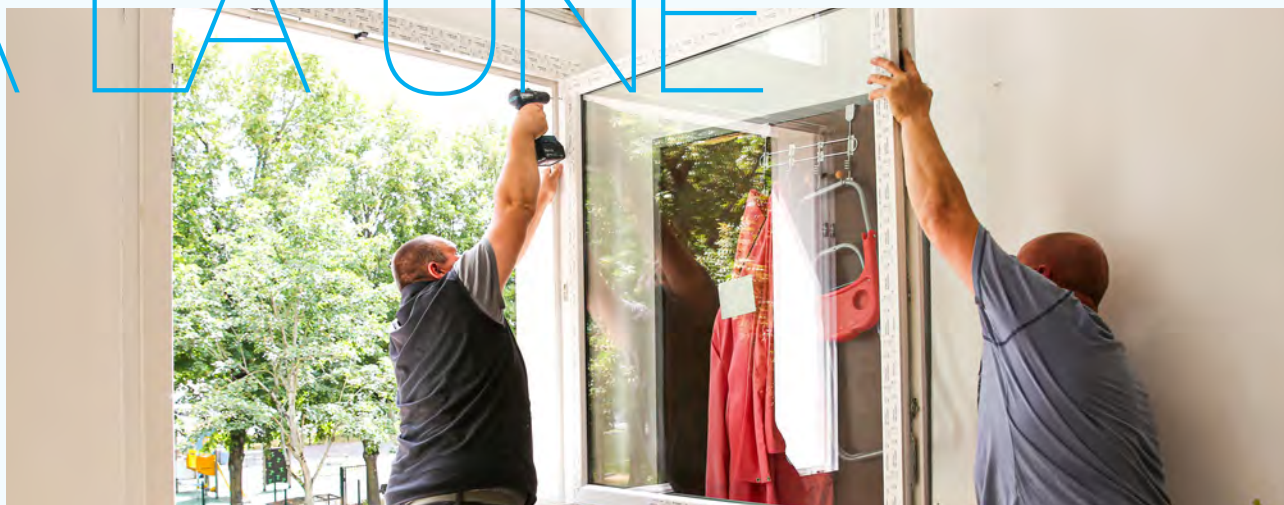
Remplacement des menuiseries du groupe scolaire Branly.
