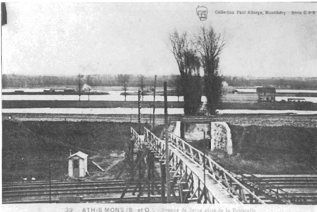
39. - ATHIS MONS (S - et O.) - Avenue de Seine prise de la Passerelle.
