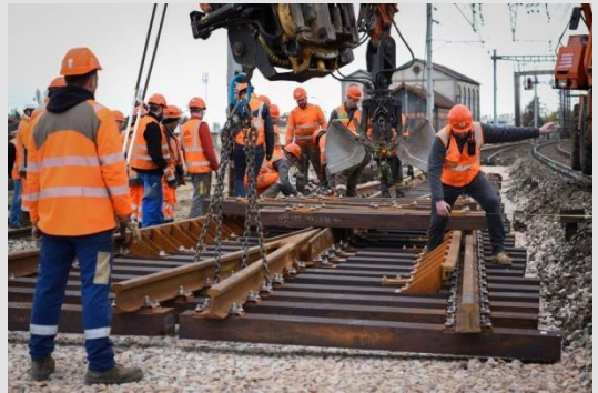
Renouvellement d'aiguillage
