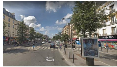
Le Kremlin-Bicêtre – RD7
